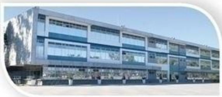
Dirección General de Administración (DIGA) Es uno de los edificios más nuevos de la Usac, en este se encuentra Registro y Estadística.
